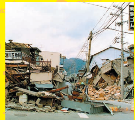
神戸市東灘区本山南町付近(写真提供:神戸市)
