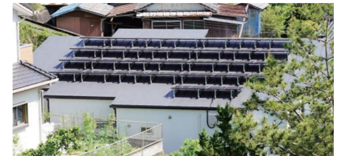
当初はパネルをそのまま屋根に設置する予定でしたが、反射光などの問題から架台をつけて設置。架台は屋根の凹凸に挟み込んで設置するタイプなので、屋根に穴は開けていません。
